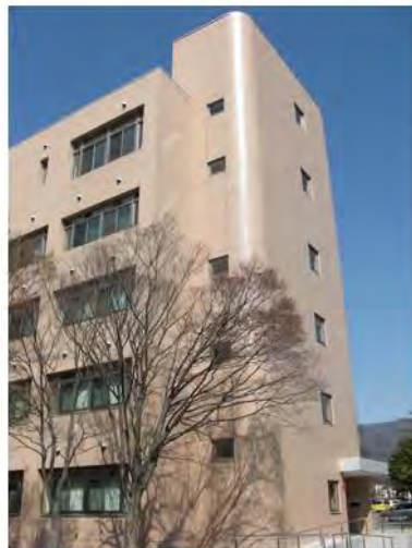
改修の終了した電子情報工学科棟
